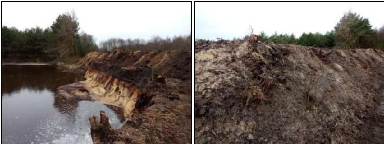
Abb. 26+27: Anlage eines Walles als Pufferstreifen (links), Einbau von Baumwurzeln und Jungbäumen (rechts)
