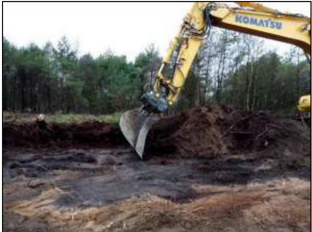
Abb. 18+19: Maschinelle Entnahme von Stubben und Oberboden
