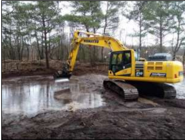
Abb. 8+9: Teilentschlammung (links) Uferabflachung (rechts)
