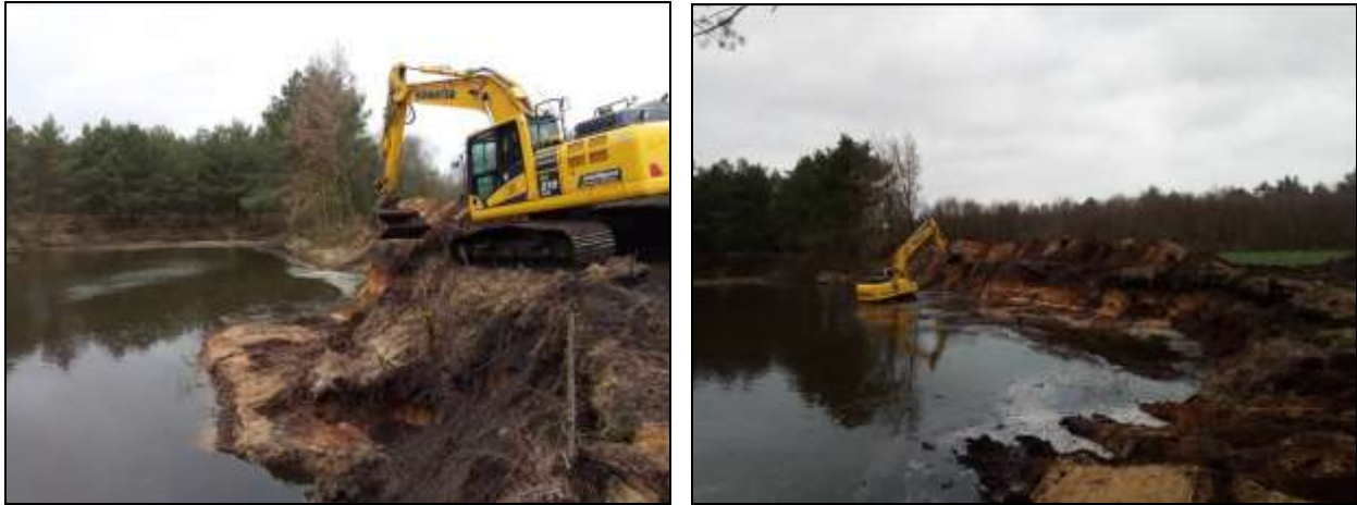
Abb. 4+5: Anlage der Steilwand mit einem Bagger
