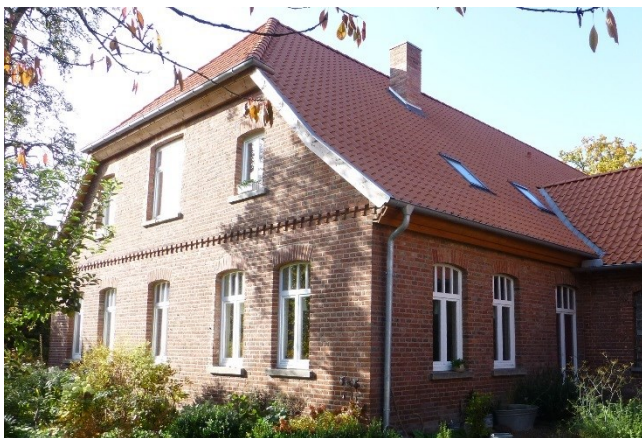
Umfassend saniertes Gebäude – Dach, Fenster, Steinverfugung
